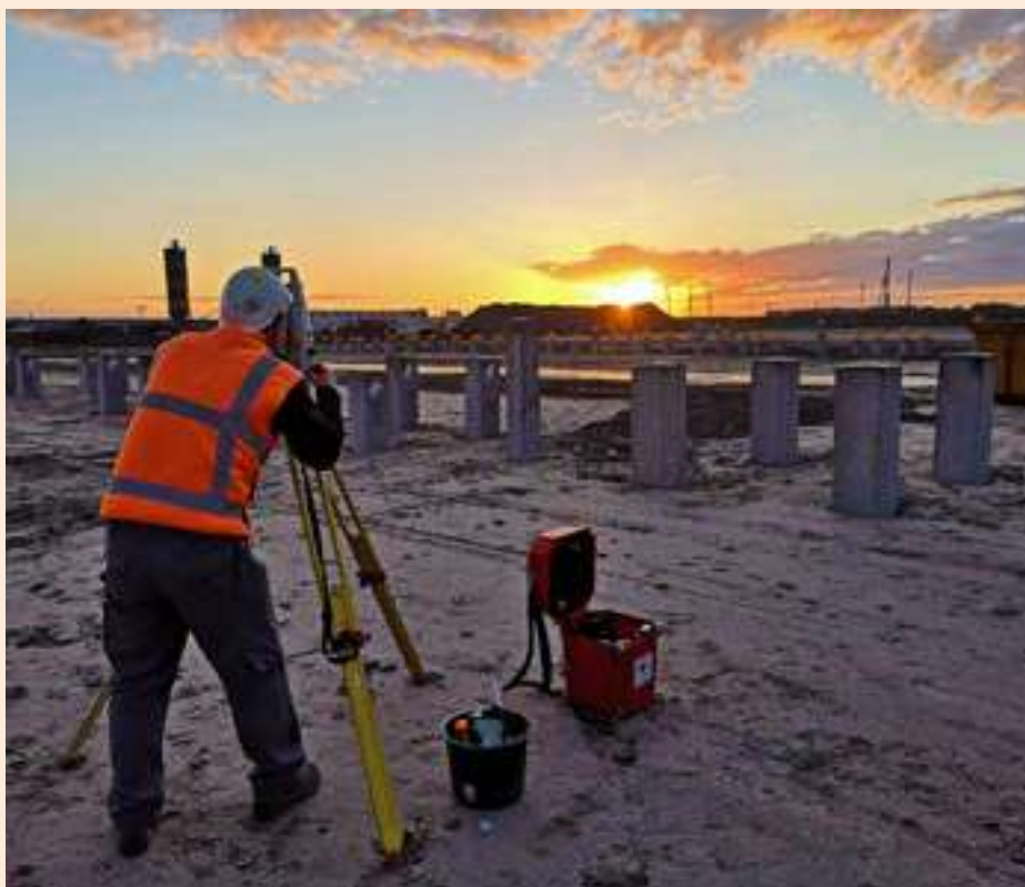
Nieuwbouw Lidl Almere
